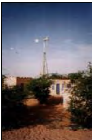
Électrification d'un poste de santé à Tighent à partir d'un aérogénérateur de marque Marlech de 250 W.
