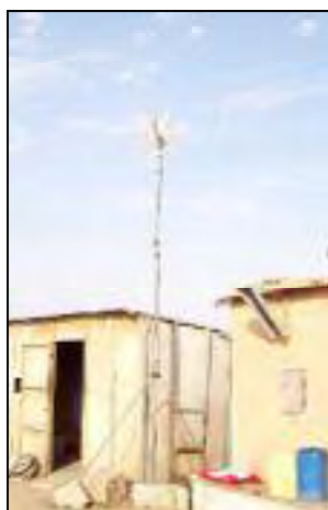
Éclairage d'un poste de police à Rosso par un aérogénérateur de marque Marlech (70 W).
